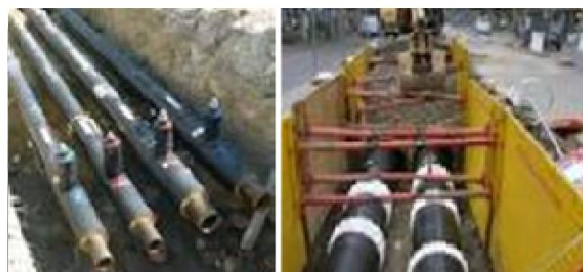
Réalisation de travaux de construction tels que tranchées et formation de réseaux de distribution télé-chauffage pour bâtiments industriels et résidentiels.
